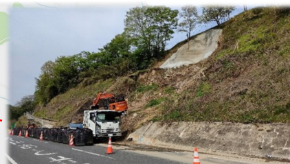
①R2災(R4年4月から片側交互通行) 復旧工事発注済み((株)井原組) R4年8月末までに工事完了予定
