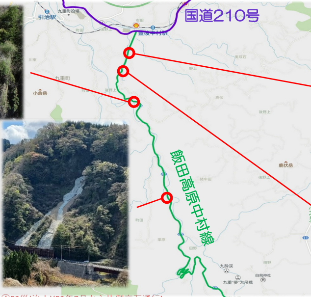
④R2災(治山)(R2年7月から片側交互通行) 法面上部から落石の可能性があるので 復旧工法検討中
