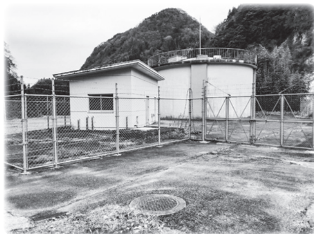
野上水系の配水池
