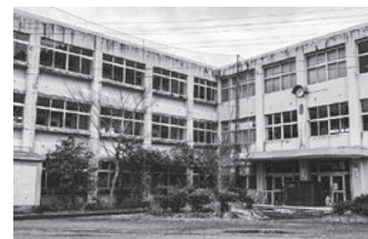
老朽化して解体予定の旧野上中学校舎
