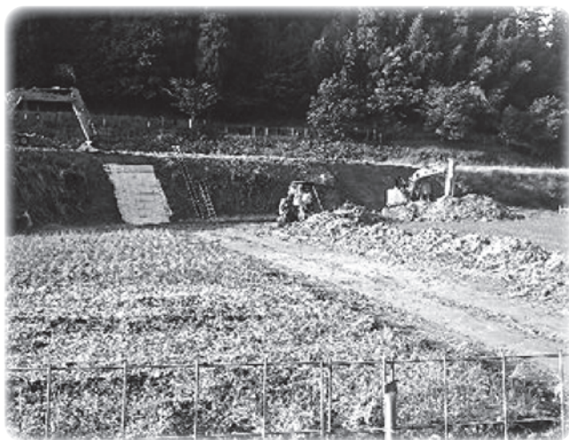
農地の災害復旧工事の様子
