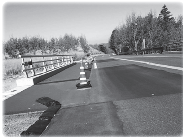
県道11号線の歩道工事中
