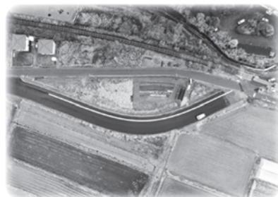
町に移管される道路周辺
