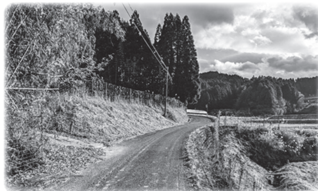
今後、改良工事が見込まれる町道
