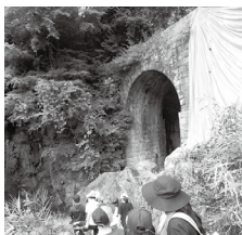
通水橋を見学
