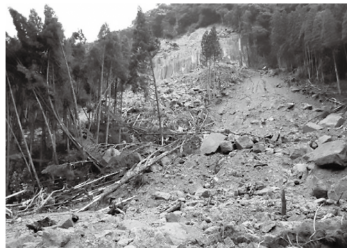
▲平成28年熊本地震の際に九重町内で発生した崖崩れ
