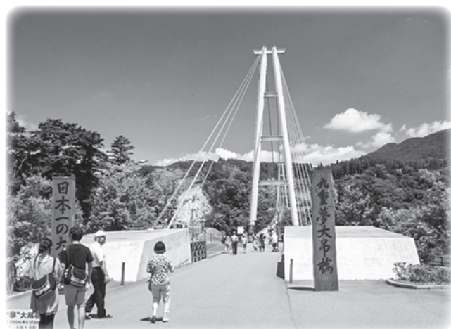
九重“夢”大吊橋
