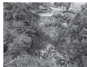
馬子草線道路災害箇所
