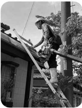
高所作業もなんのその！
