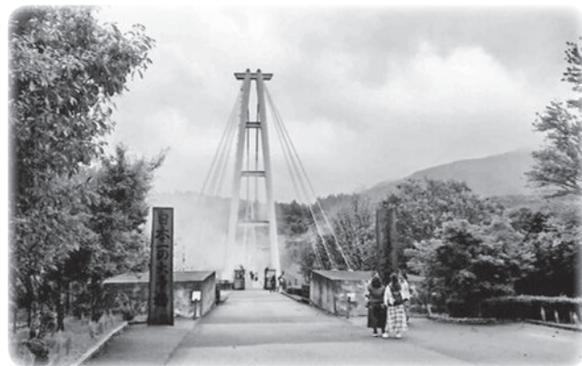
九重“夢”大吊橋
