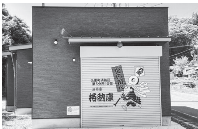
後野上消防詰所新築工事及び付帯工事
