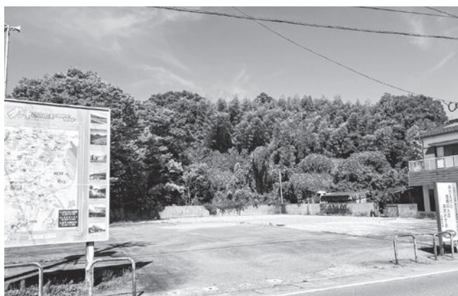
農民研修センター解体工事
